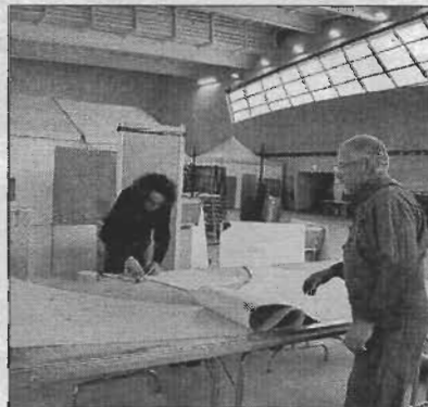
Les espaces réservés aux industriels sont en cours de montage. Photo M. J.
