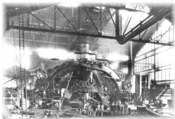
Marteau-pilon de 100 T., emblème du Creusot, tel qu'il était installé dans les usines Schneider du Creusot en 1880 (Collection Académie François Bourdon cote 01PHINSTIND0019)
